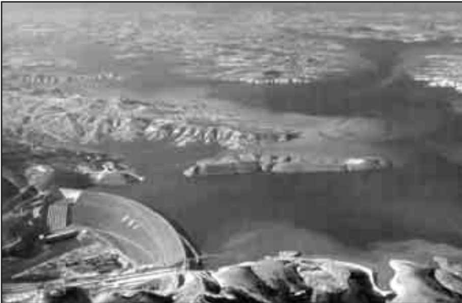
Keban Barajı'nın inşa edilmesiyle nehrin suyu durdurulmuştur.
